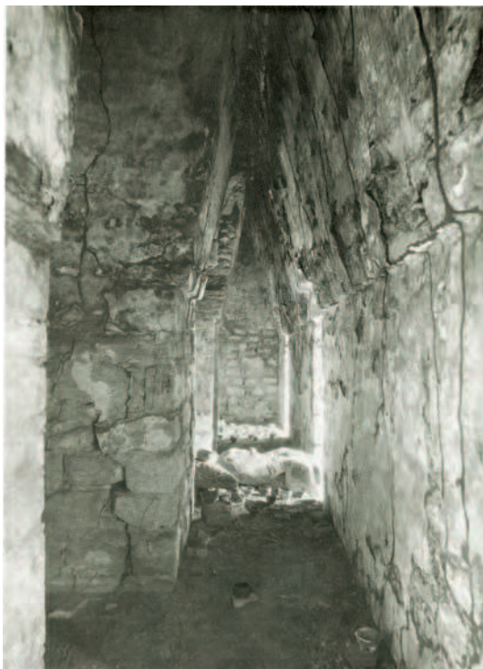
Figura 201. Nótese la estatua de Hach Ak Yum y los incensarios lacandones depositados. Edificio 33 de Yaxchilán. Fotografía: Maler, 1901, lám. XLV.
